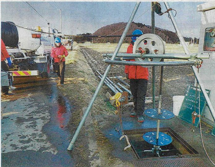
ユニバーサル洗浄用のやぐらを組み、井戸に下ろす。スルの先端から出る高圧水が漏れていないか、スムーズに回転するかなどを検査する担当者(福井県内)で
